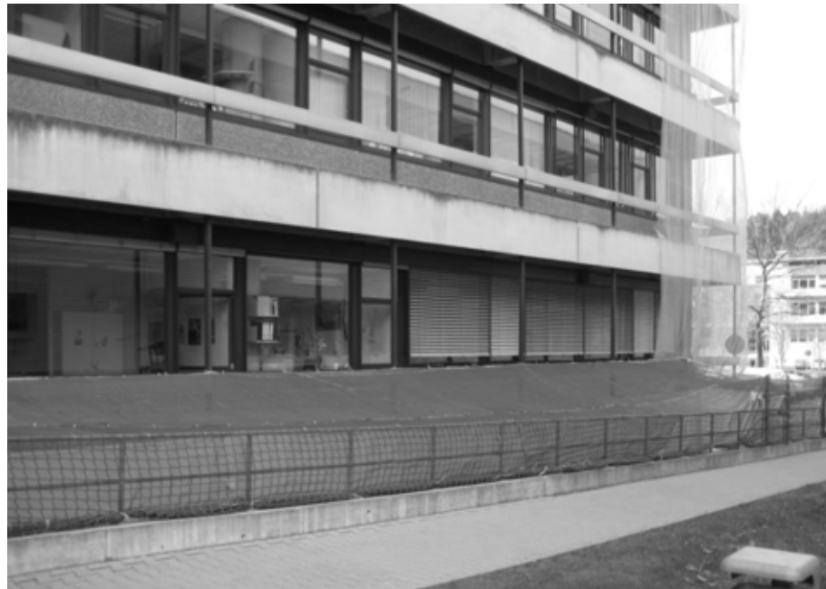
Abbildung 1: Schutzeinhausung gegen herabstürzende Bauteile
