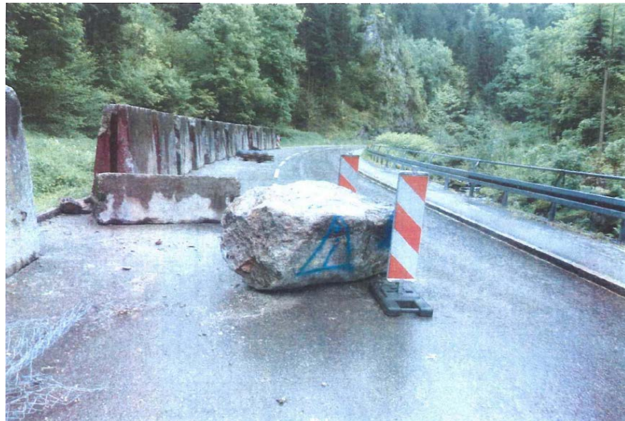
Abbildung 2: Felsschlag an der L 175 Schramberg-Tennenbronn, Regierungsbezirk Freiburg
