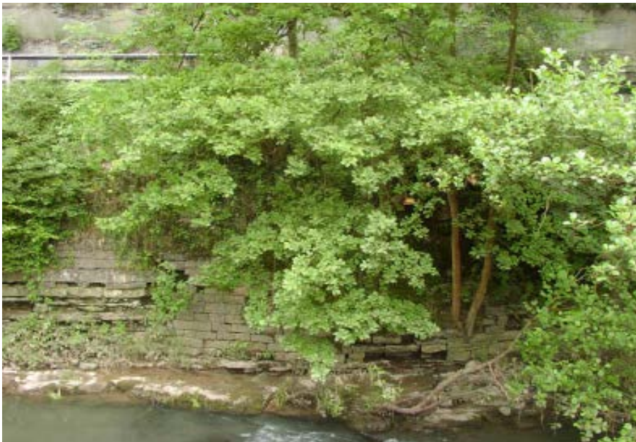
Abbildung 1: Stützbauwerk an der L 526 bei Untergriesheim, Regierungsbezirk Stuttgart
