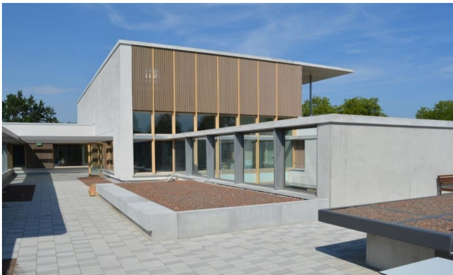
Abbildung: Dachterrasse der Alterspsychiatrie in Reichenau
