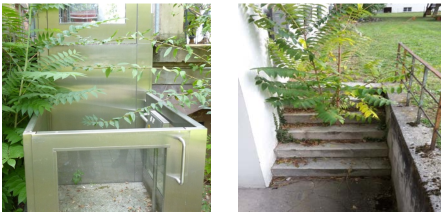
Abbildung 1: Behindertenaufzug als Zugang zu einer Behördenkantine und der Außenabgang zu einem Gebäude
