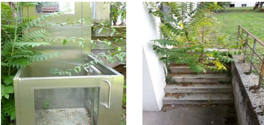
Außentreppen wiesen häufig Verschiebungen, Setzungen oder Verwerfungen auf. Die ungenügende Reinigung von Treppen, wie z. B. die Entfernung von Laub, schränkten die Verkehrssicherheit zusätzlich ein. Mit Hecken zugewachsene Toranlagen und defekte Zäune waren keine Seltenheit. Zaunanlagen, die von angrenzenden Grundstücken aus überwuchert wurden, stellten ein Risiko für Sicherheitsbereiche dar, zum Beispiel bei einer Justizvollzugsanstalt oder einem Polizeiareal.
