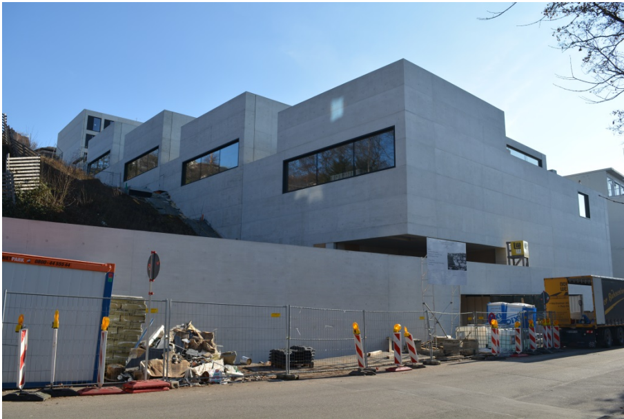
Abbildung 2: Baustelle der John-Cranko-Schule (Februar 2019)
