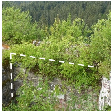
Abbildung 1: Durchwurzelte Mauern
