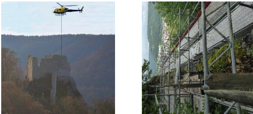
Abbildung 2: Helikoptereinsatz und Hängegerüst am Rusenschloss
