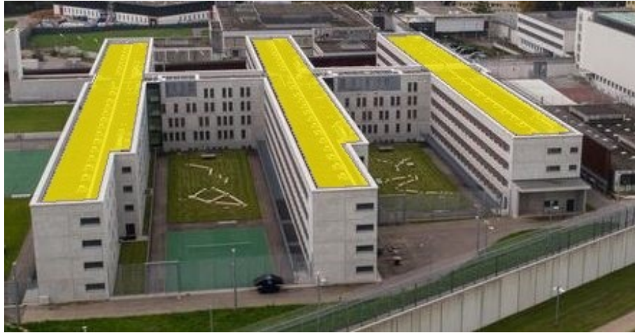
Abbildung 2: Nicht genutzte Dächer (gelb) der Justizvollzugsanstalt Stuttgart
